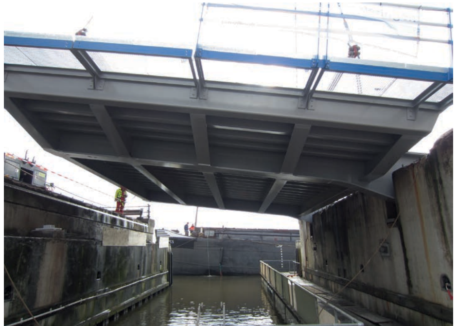
Gerenvoerde val Kruiswaterbrug, met vijf dwarsdragers en inspectiepad met roosters.
